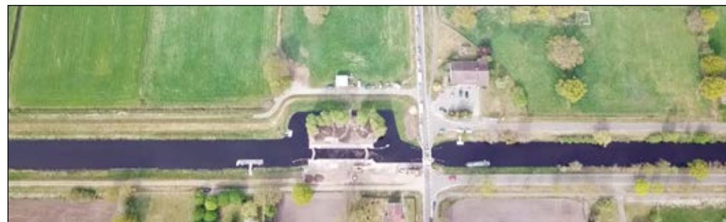
Die Schleuse Osterhausen ist wieder befahrbar.
